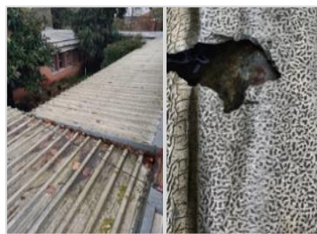
Pormenores da cobertura do Palácio da Justiça de Rio Maior
